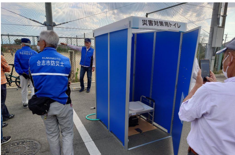
支部内の訓練模様(マンホールトイレの組立)
