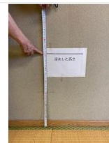
【建物内部の浸水した深さを撮る …遠景】
