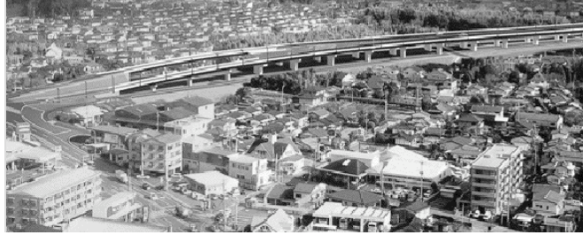
建設中の北バイパス
