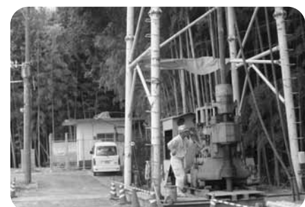
木原野第2水源天井戸移設工事
