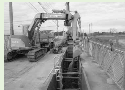
竹迫污水幹線管渠築造工事(工事中)
