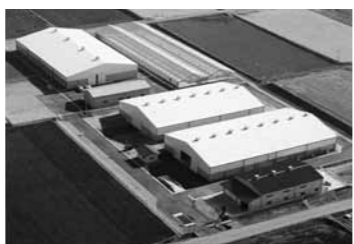
合志バイオX堆肥製造施設
