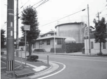
泉ヶ丘配水池(貯水タンク)
