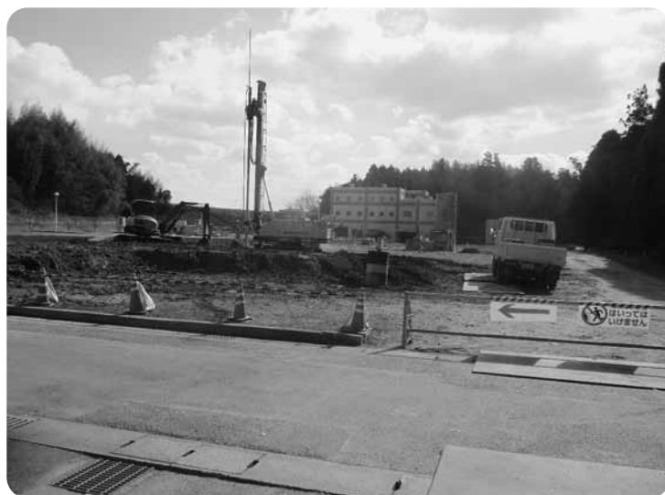
塩浸川浄化センター改築工事
