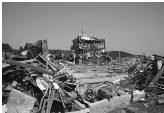
津波被害にあった南三陸町防災センター
