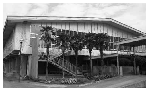
現在の西合志南中学校体育館
