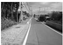
歩道整備工事現場
