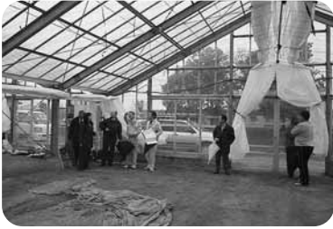
ガラスハウス改修工事現場
