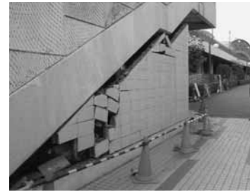
浦安市災害現場
