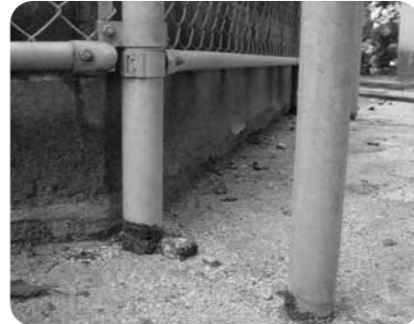
福原グラウンド (バックネット支柱の錆状況)
