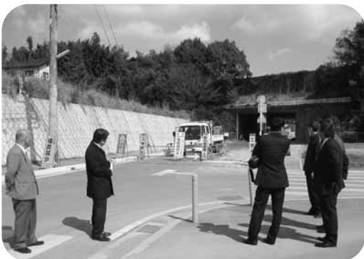
三ツ石交叉点現場
