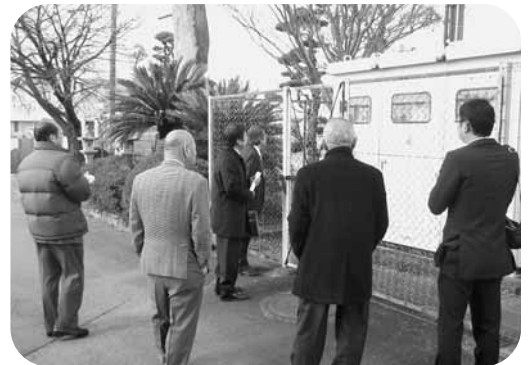
西合志庁舎受変電設備
