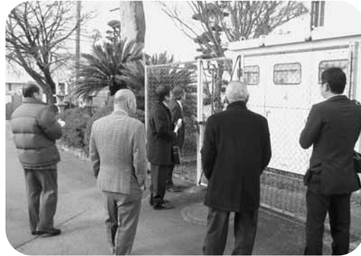
西合志庁舎受変電設備
