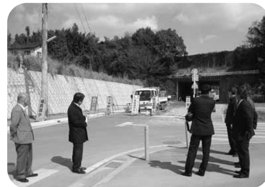
三ツ石交叉点現場
