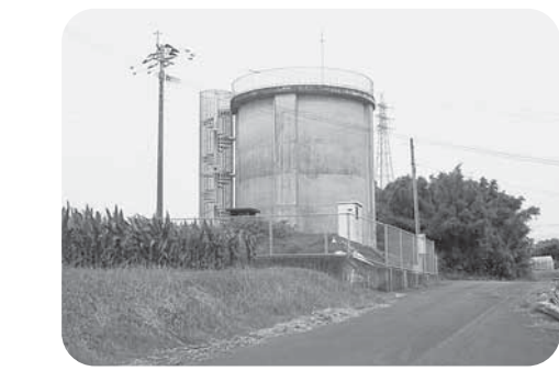
竹迫第1配水池改良工事現場
