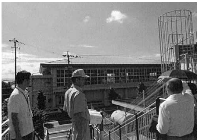
▲改修された泉ヶ丘体育館
