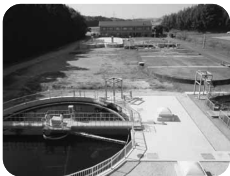
完成した「塩浸川浄化センター増設工事」
