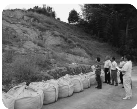
立割萩迫線（路肩崩壊）
