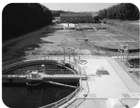
完成した「塩湊川浄化センター増設工事」
