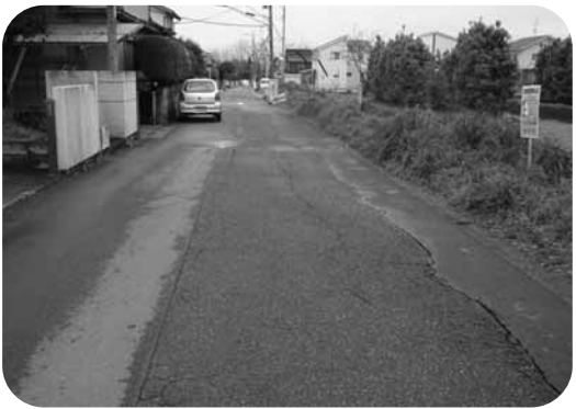
拾八町笹原線改良予定現場
