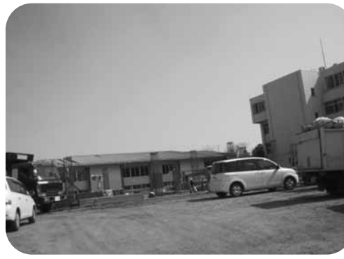
西合志南中武道場工事現場
