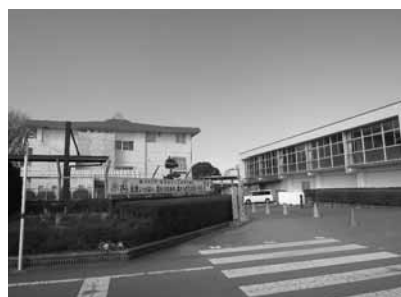
大規模化がさらに進む西合志東小学校
