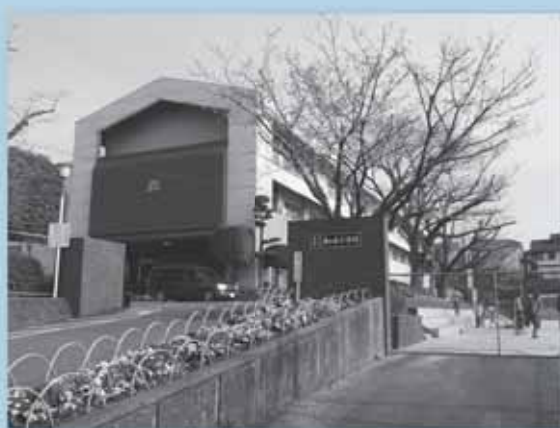
合志南ヶ丘小学校4教室増築
