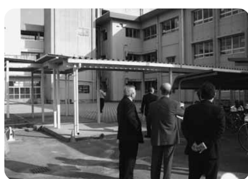
合志中増築予定現場
