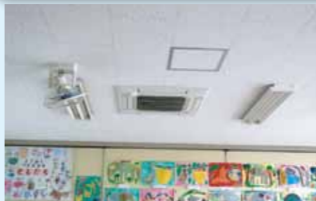
設置されたエアコン
