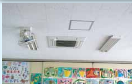
設置されたエアコン
