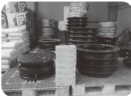
マンホール改良工事分資材
