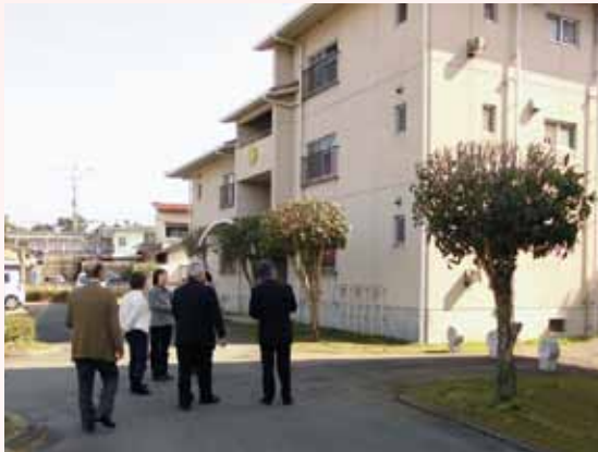
御代志住宅(現況)
