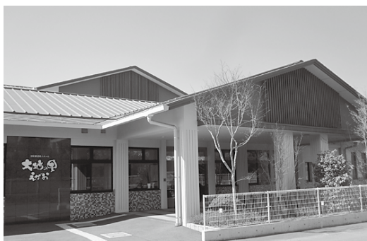
新設された特養ホーム
