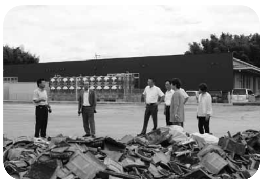
台風15号によるガレキ類仮置き場(給食センター)
