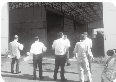
台風15号の被害視察の様子 (バイオエックス)
