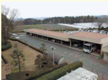
増築予定地(合志庁舎北側)
