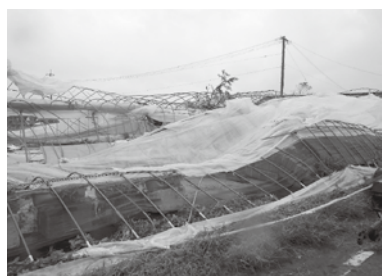
台風で壊されたビニールハウス
