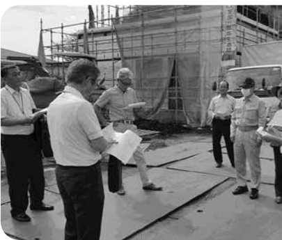
地域密着型特別養護老人ホームヒューマン・ケアたかばの杜(二子区)新設工事
