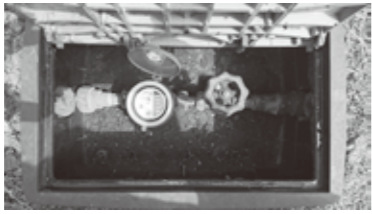
水道メーター
