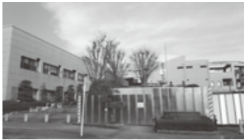
改修工事が始まったヴィーブル
