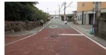
舗装打ち換え予定道路(須屋)
