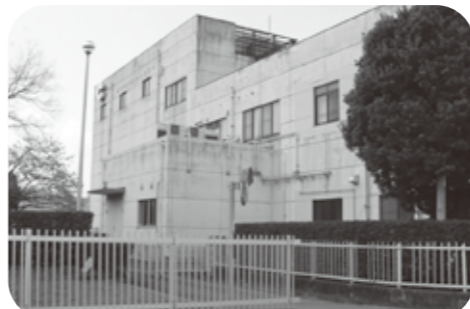
須屋浄化センター
