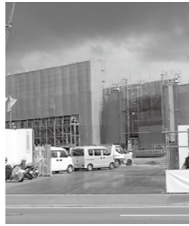
建設中の熊本北合志警察署
