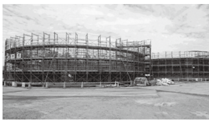
建設が進む木原野配水池
