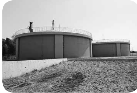
木原野配水池
