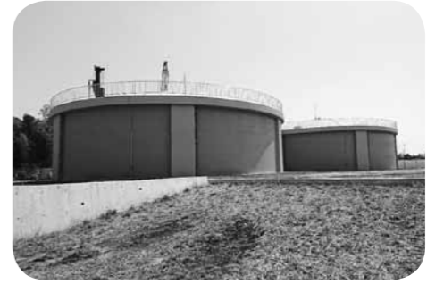
木原野配水池
