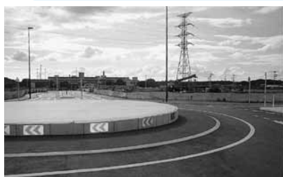
建設中のアンビー熊本
