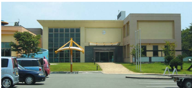
合志町南部町民センター
