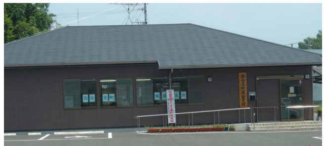
西合志町南部支所
