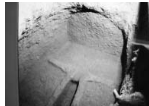
横穴内部 (12号基上部から)
