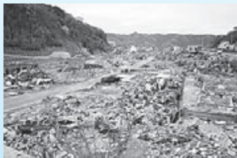
▲いまだにがれきの撤去が進んでいない地域も多い。
