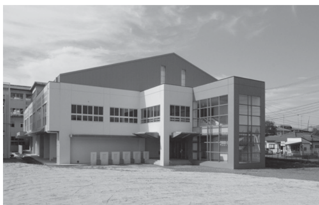
西合志南中学校新体育館
