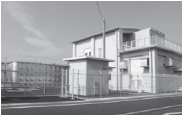
御代志第2配水池は、市で初めてのステンレス製配水池です
