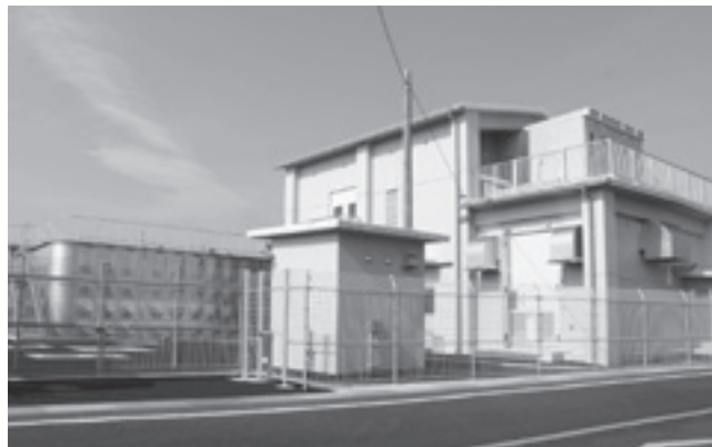
御代志第2配水池は、市で初めてのステンレス製配水池です
