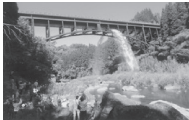
豊潤橋からの放水
