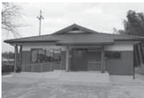
大池区 公民館の建設
