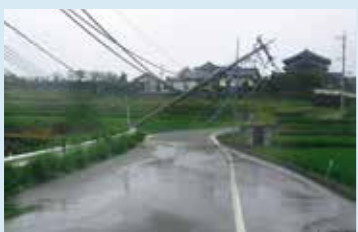
道路に倒れかかった電柱
