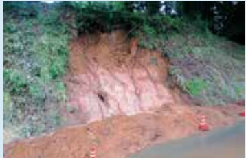
道路になだれ込んだ土砂
