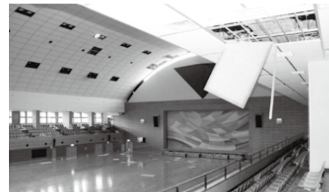
多数の天井パネルがはがれ落ちたヴィーブルのメインアリーナ
