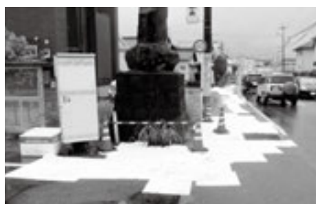
道路に敷き詰められた油吸着マット。流出した油の回収には多大な時間と費用を要します
